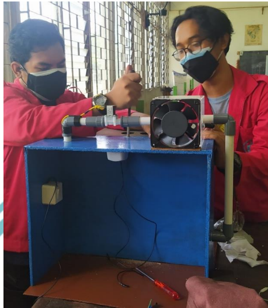
Gambar L. 22 Pemasangan Panel pada Miniatur Fan Coil Unit
