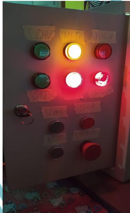
Gambar L. 25 Pengujian Gangguan Sistem Fan Coil Unit
