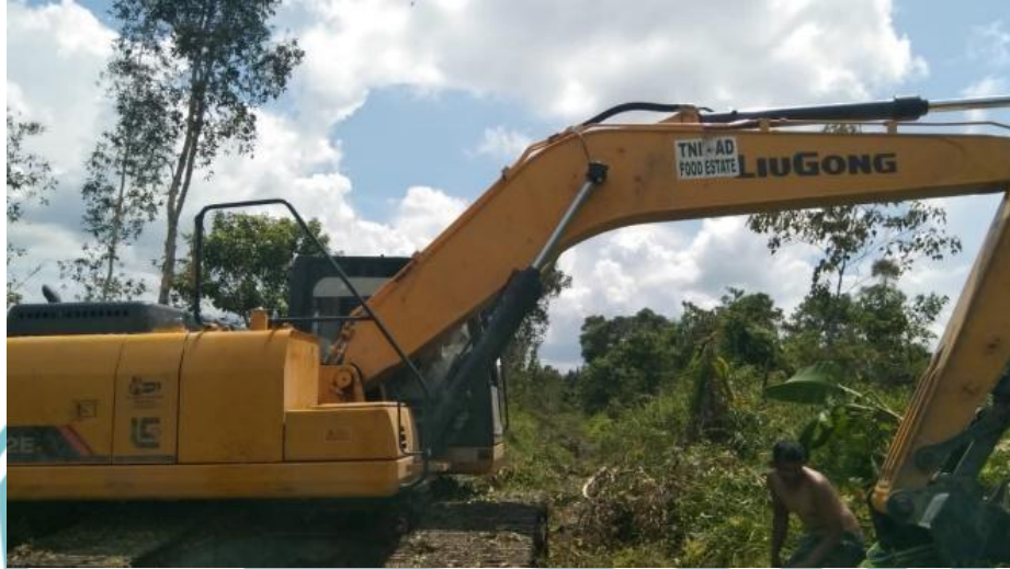
Kondisi Spare Part yang rusak
