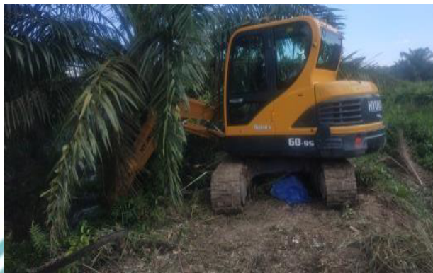
Foto unit beroperasi setelah melakukan perbaikan.
