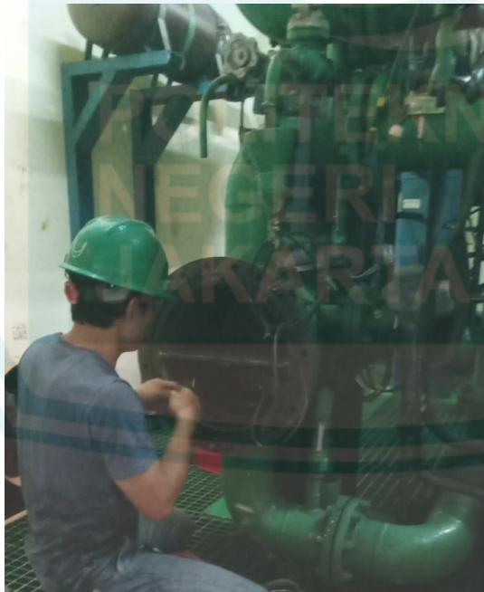
Gambar 9 Pembersihan Pada Cooler
