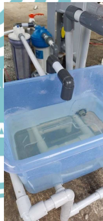
Gambar 16 Hasil Akhir Pengolahan Air Limbah dengan Unit Mini WWTP
