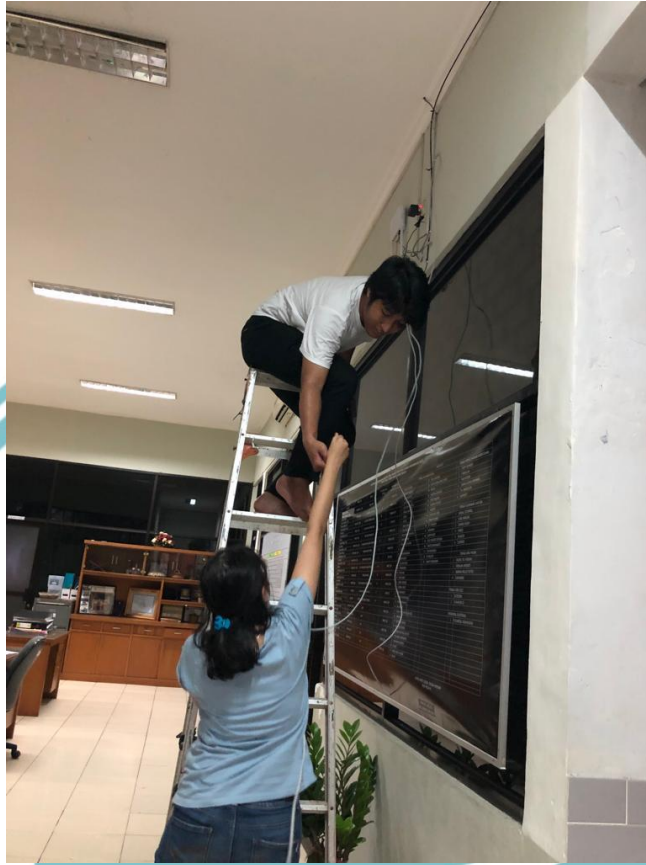
Pemasangan Kabel LAN dan Kelistrikan di Panti
