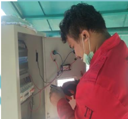
Proses wiring pada panel distribusi
