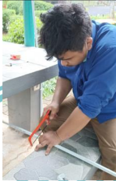
Pemotongan pipa PVC sebagai pelindung kabel instalasi
