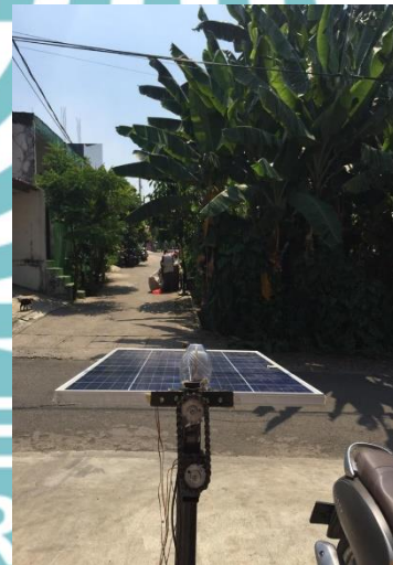
Foto 4. Kondisi Solar fixed
