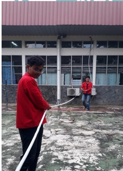
Penarikan kabel dari tiang PLTS ke panel desk di dalam bengkel
