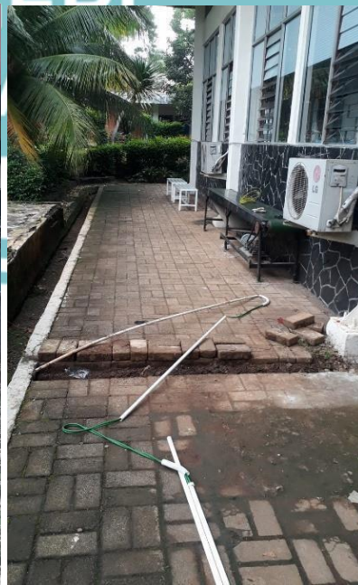
Penarikan kabel dari tiang PLTS ke panel desk di dalam bengkel
