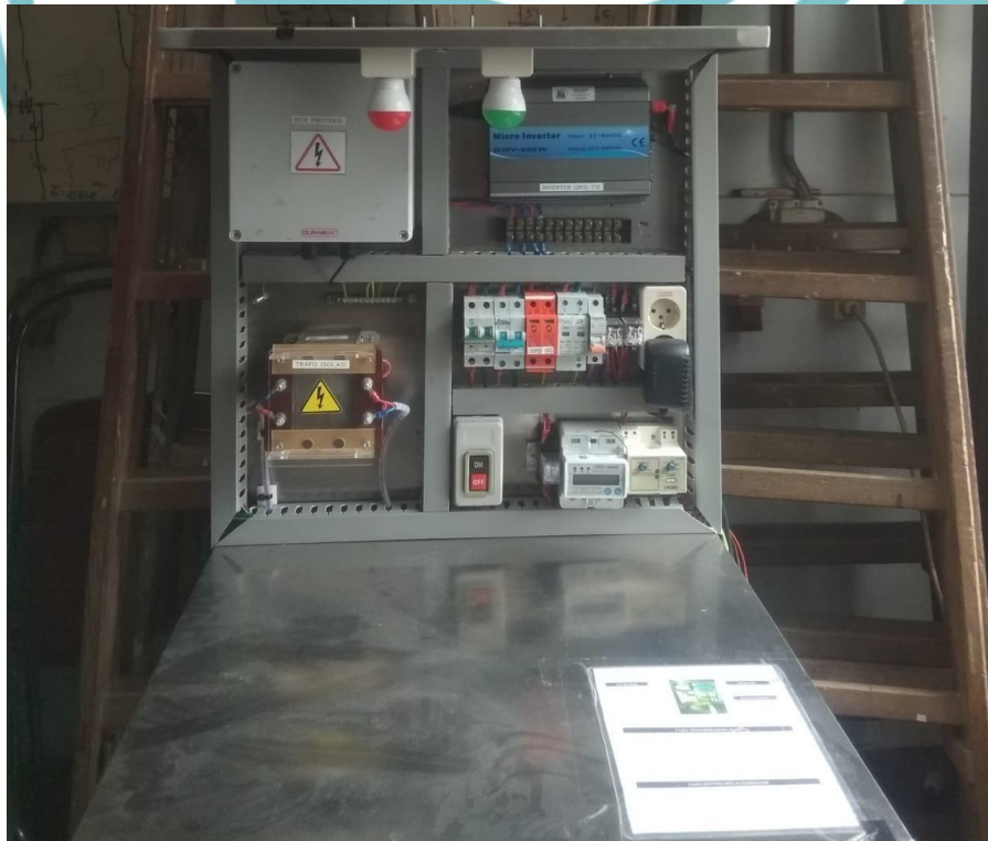
Gambar panel setelah dilakukan rekonstruksi
