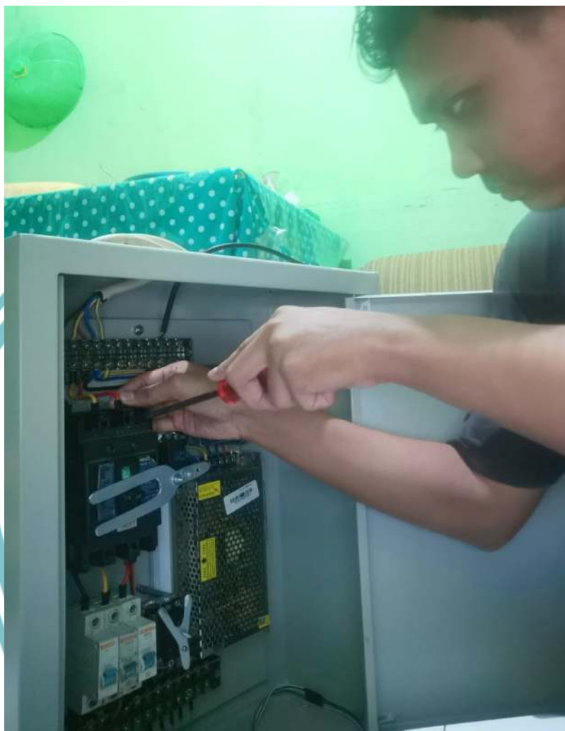
Lampiran 3. Proses Wiring Prototipe Pengendali MCCB dan MCB PHB-TR pada Simulasi Banjir Berbasis Internet of Things (IoT)
