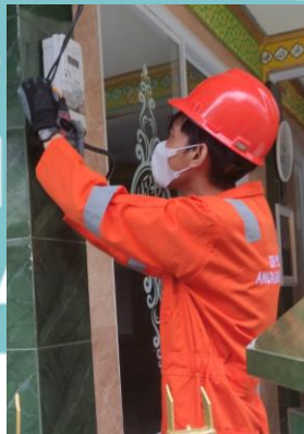
Gambar 3. 17 Melakukan Pergantian Meter AMI 1 Fasa (Sumber: Dokumen Pribadi)
