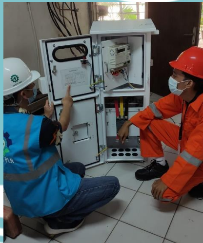
Gambar 3. 9 Mempelajari Wiring Meter Elektronik (Sumber: Dokumen Pribadi)
