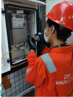
Gambar 3. 15 Melakukan Pemasangan Rellay Shuntrip (Sumber: Dokumen Pribadi)
