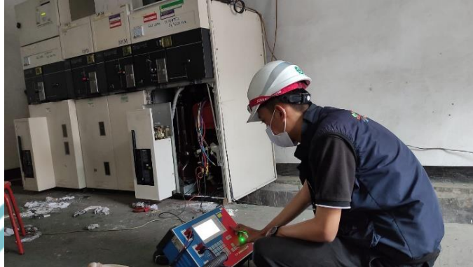
Gambar 3. 24 Melakukan Proses Revisi Kubikel
