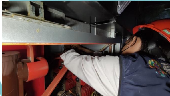
Gambar 3. 21 Melakukan Penggantian Wiring Kabel 6 m
