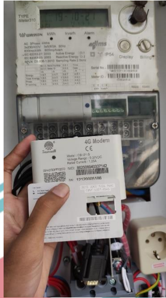
Gambar 3. 5 Pemasangan Peralatan AMR
