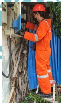
Gambar 3. 19 Melakukan Pergantian Meter AMI 3 Fasa
