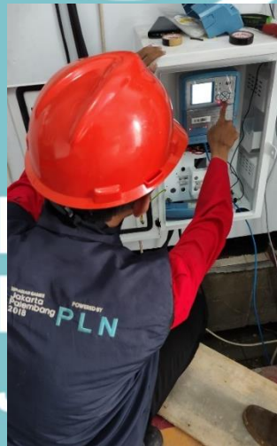
Gambar 3. 20 Mempelajari Proses Pemasangan DCU
