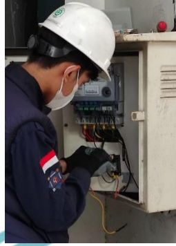
Gambar 3. 12 Mempelajari Proses Pemasangan Relay Shuntrip
