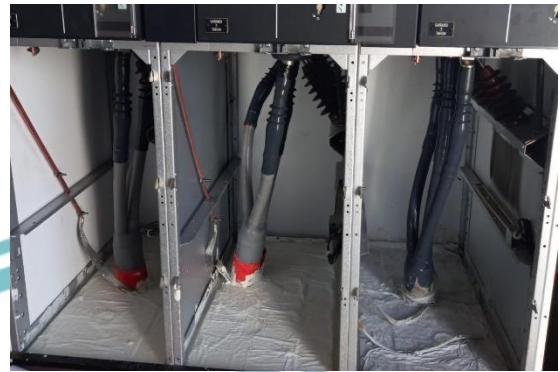
Gambar 3. 89 Penutupan lubang indoor kubikel
