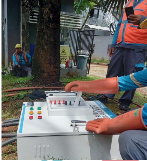
Gambar 3. 76 Menyalakan saklar panel sinkron
