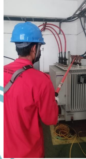
Gambar 3. 77 Pengecekan tegangan pada transformator
