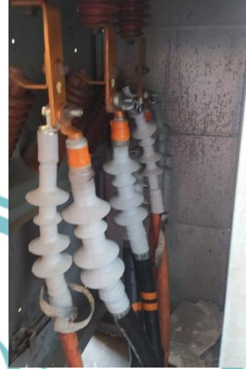
Gambar 3. 68 Pengkonekan kabel UTB dengan Kubikel
