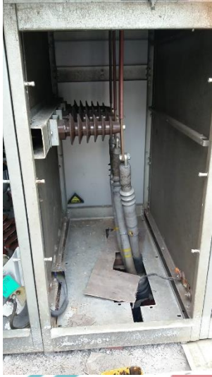
Gambar 3. 84 Lubang pada indoor kubikel
