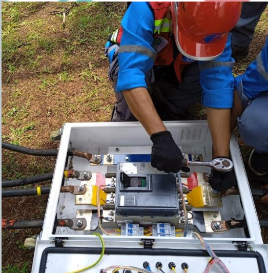
Gambar 3. 73 Pengkonekan kabel ke sinkron
