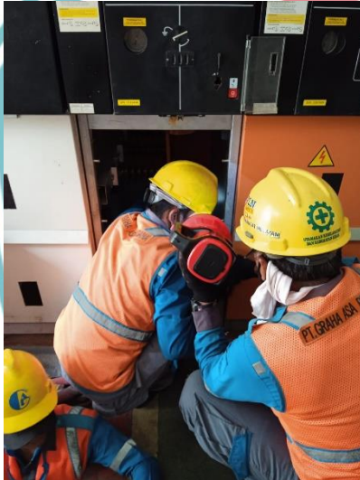
Gambar 3. 86 Pemeliharaan pada bagian kubikel
