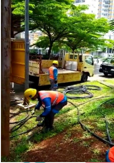
Gambar 3. 67 Gelar Kabel UTB
