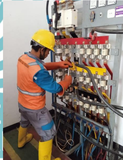
Gambar 3. 70Pengkonekan kabel ke PHBTR
