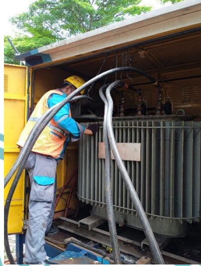
Gambar 3. 72 Pemasangan kabel di UTB
