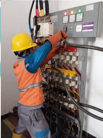
Gambar 3. 69Pengkonekan kabel ke PHBTR
