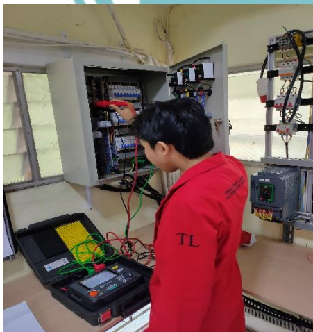
Lampiran 4.1 Kegiatan Proses Wiring dan Pengujian pada Power Panel
