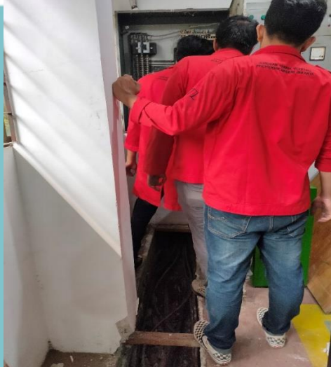
Lampiran 3.1 Kegiatan Penarikan Untuk Kabel Incoming Power Panel
