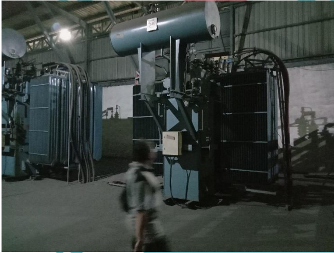
Ruang Trafo Substansi 2
