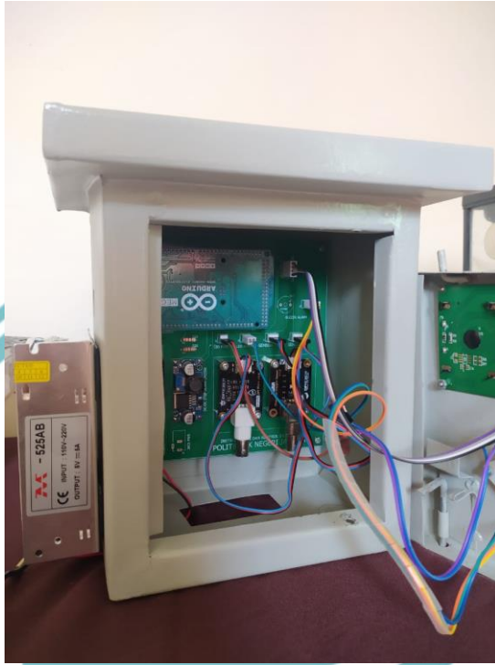
Foto 1. Tampak Dalam Box Panel
