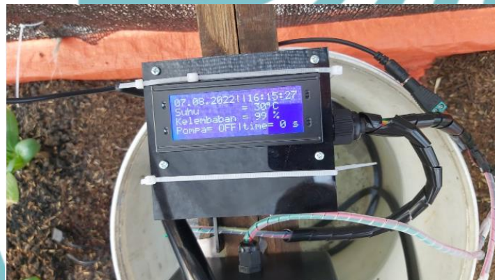
Gambar L- 2 Instalasi Panel 1 (TX)
