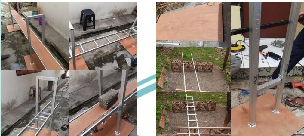
Foto 1. Pengerjaan Miniatur Jembatan
