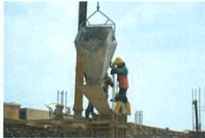
Gambar 20 . Pengecoran Kolom
