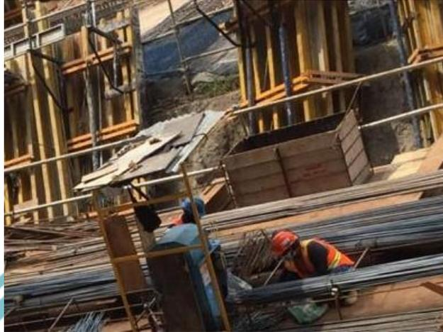
Gambar 5.43 Pemotongan Besi Tulangan dengan *Bar Cutter*
