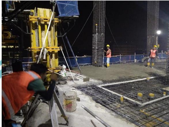
Gambar 5.50 *Monitoring Elevasi Permukaan Beton Pelat Lantai oleh Surveyor*
