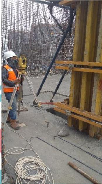
Gambar 5.4 Surveyor Melakukan Pembidikan 2 Gedung untuk *Marking* Kolom
