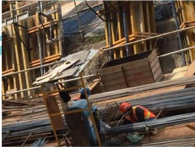
Gambar 5.9 Pemotongan Besi dengan *Bar Cutter*
