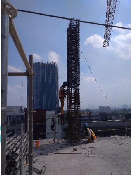
Gambar 5.12 Penyambungan Besi Tulangan Kolom dengan Stek Kolom
