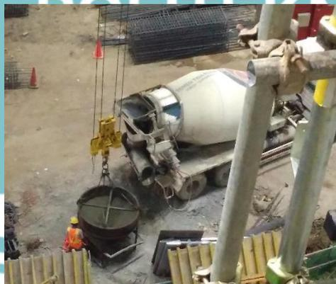
Gambar 5.24 Penuangan Beton Ready Mix ke Concrete Bucket
