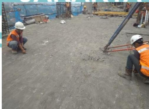
Gambar 5.6 Pembuatan Garis dengan Penyipatan
