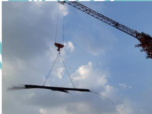
Gambar 5.44 Pengangkutan Besi Tulangan Balok dan Pelat Lantai dengan *Tower Crane*
