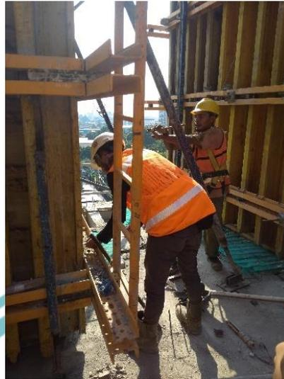
Gambar 5.18 Pengecekan *Bekisting* Kolom
