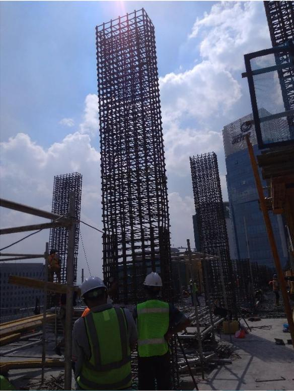
Gambar 5.14 Pengecekan Besi Tulangan Kolom
