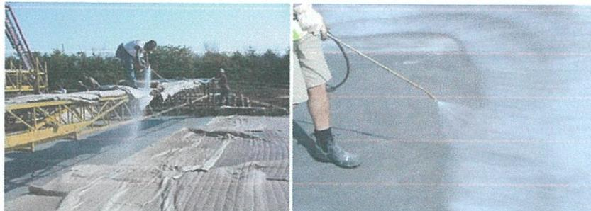
Gambar 19 . Proses Curing karung goni basah(kiri) dan Spray Curing Compound (kanan)
