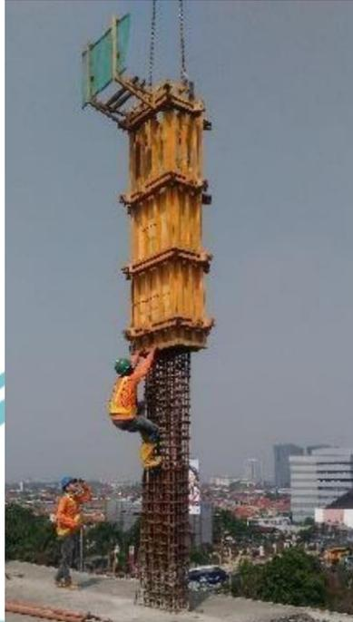
Gambar 5.17 Pemasangan *Bekisting* Menggunakan *Tower Crane*
