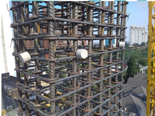
Gambar 5.13 Beton *Decking* Pada Pembesian Kolom
