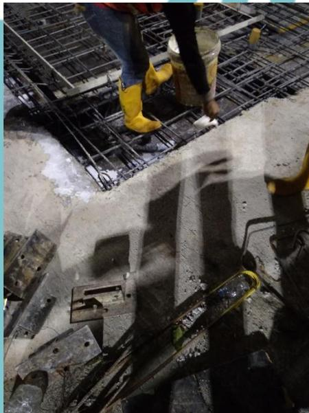
Gambar 5.47 Pemberian *Calbond* Pada Permukaan Beton Lama
