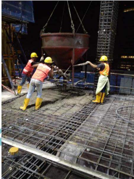
Gambar 5.48 Penuangan Beton Pada Pekerjaan Pengecoran Balok dan Slab Lantai
