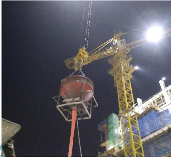
Gambar 5.25 Pengangkutan *Concrete Bucket* ke Area Kerja Menggunakan *Tower Crane*
