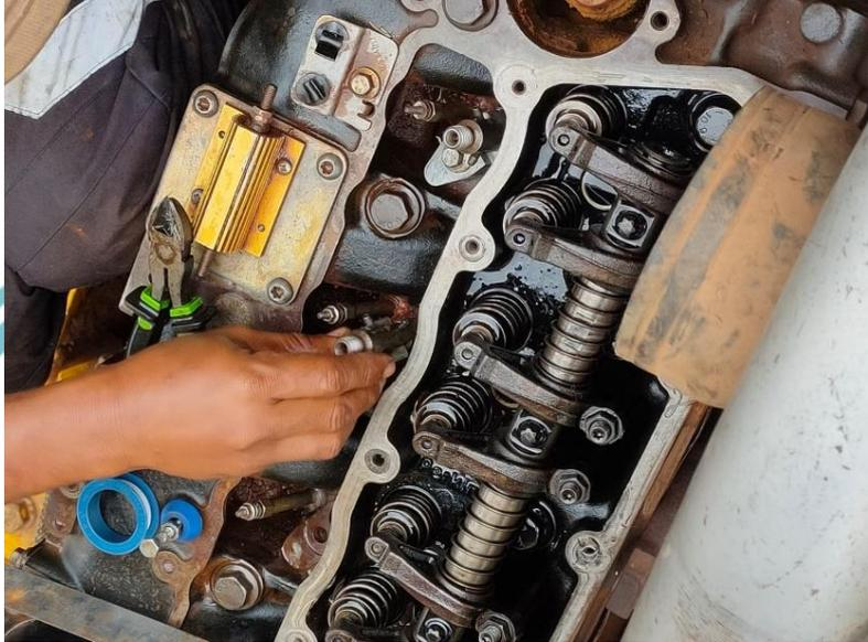
**Gambar 3.22 Proses Pemasangan *Injector***
