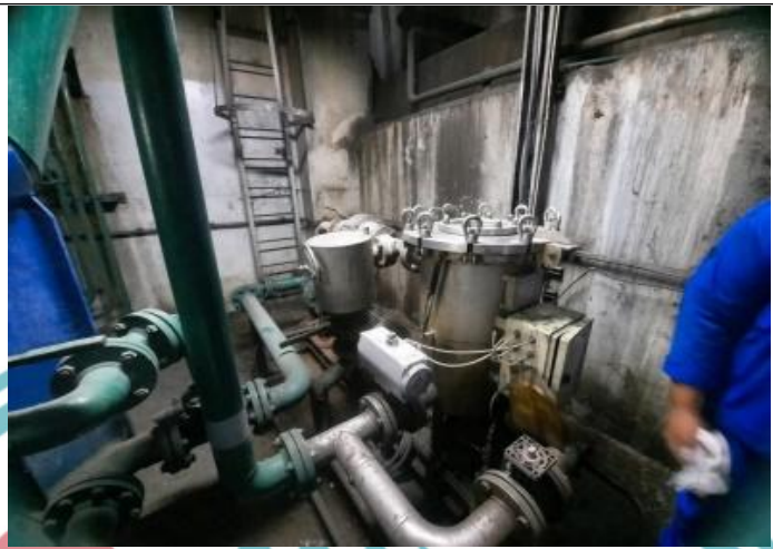
Kegiatan pembersihan sampam pada peralatan turbin pendingin pengangkatan sampah pada pipa pipa yang tersangkut
