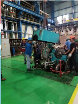
*Kegiatan Pembongkaran House Turbine dan pembukaan Turning Gear
