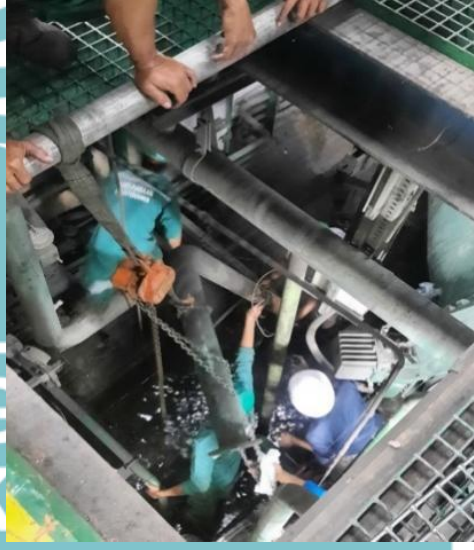
Kegiatan pembersihan sampam pada peralatan turbin pendingin pengangkatan sampah pada pipa pipa yang tersangkut
