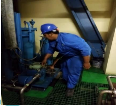
*Kegiatan Pembongkaran House Turbine dan pembukaan Turning Gear
