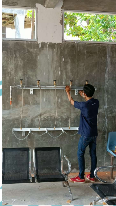
Proses penyambungan kabel di PHB dan pemasangan manifold pengisian
