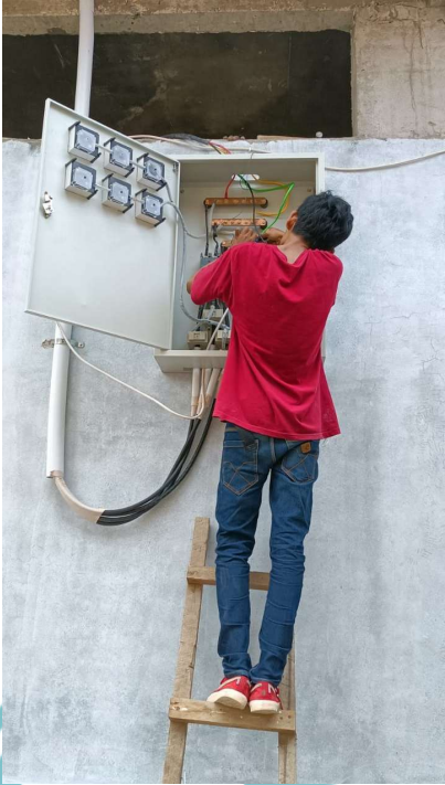
Proses penyambungan kabel di PHB dan pemasangan manifold pengisian
