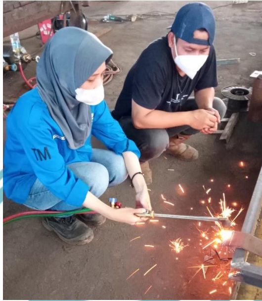
Pemotongan Menggunakan Flame Cutting
