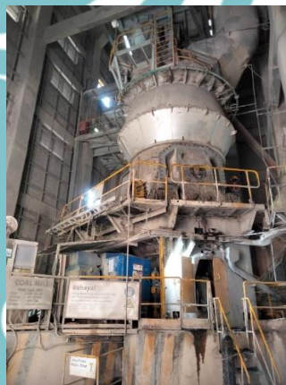
Gambar 1. 3 Coal Mill PT Solusi Bangun Indonesia Pabrik Cilacap (Sumber : Dokumentasi Pribadi)
