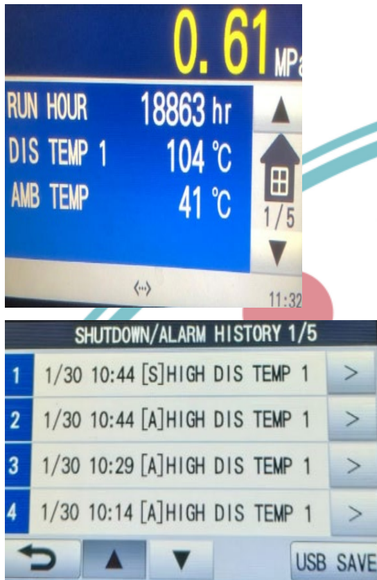
Lampiran 1.4 Data pada kontrol panel sebelum dibersihkan
