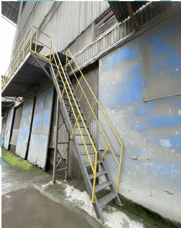
Gambar 4 21 Illustrasi Pemasangan Platform
