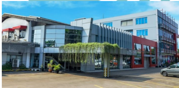
Gambar 3. 1 Gedung Pt Raja Cepat Nusantara Sumber: Data Internal Perusahaan
