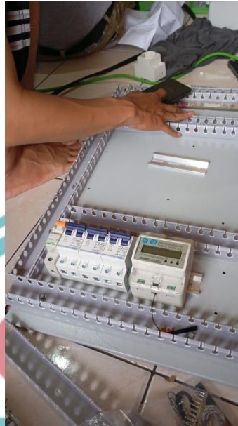
Lampiran 3 Proses pemasangan kabel duct pada box panel
