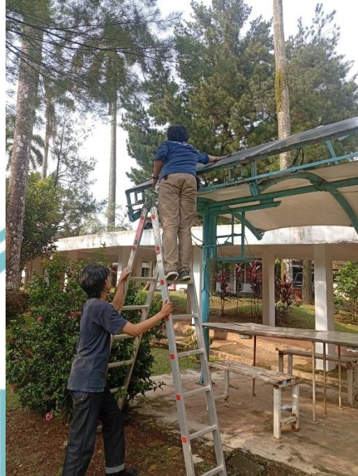
Lampiran 1 Proses Pembersihan PV menggunakan Lap dan Air
