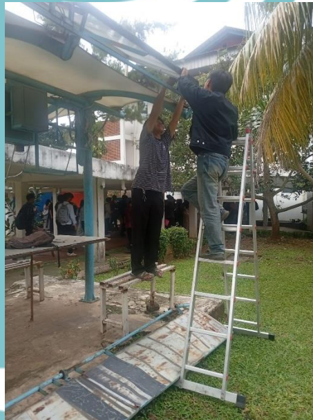
Lampiran 4 Penurunan reflektor yang lama untuk digantikan dengan yang baru
