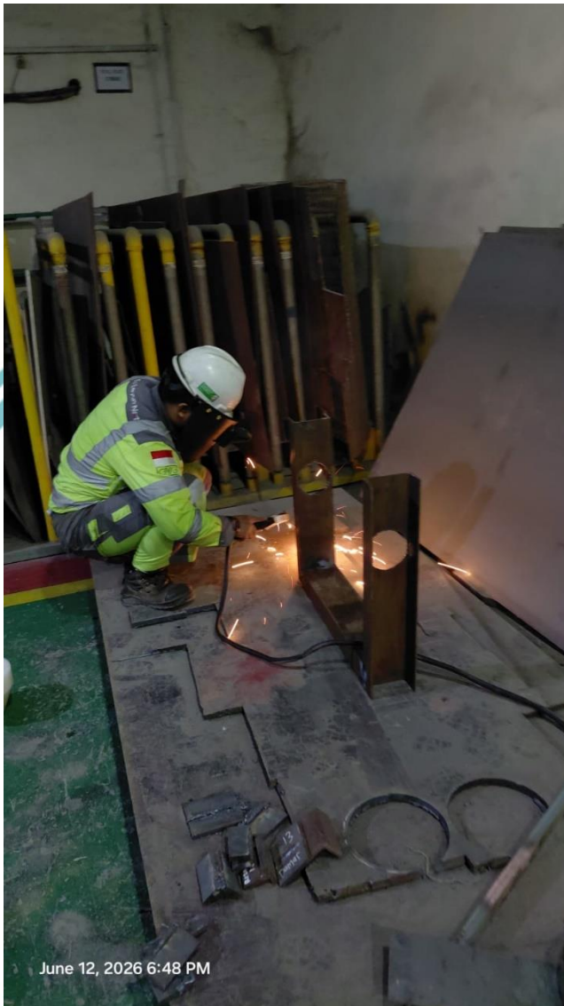
Lampiran 2. 6 Pengelasan untuk frame Line Boring
