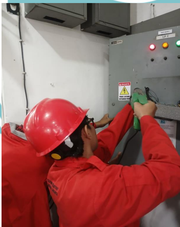
Lampiran. 4 Pemasangan Cover
