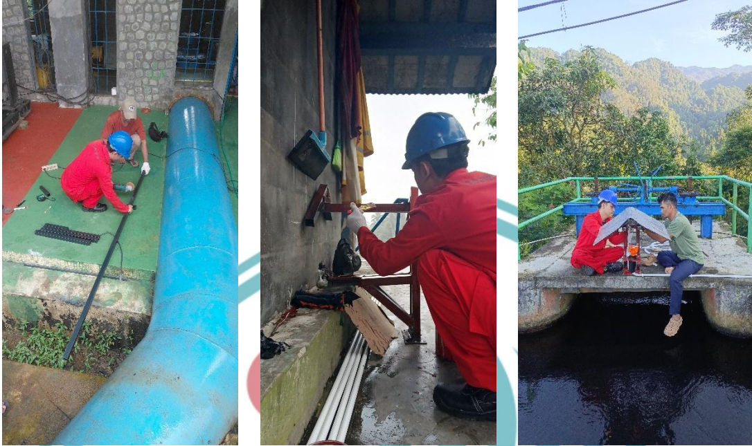
Lampiran 5.5. Pembuatan Rangka Sensor Ultrasonik
