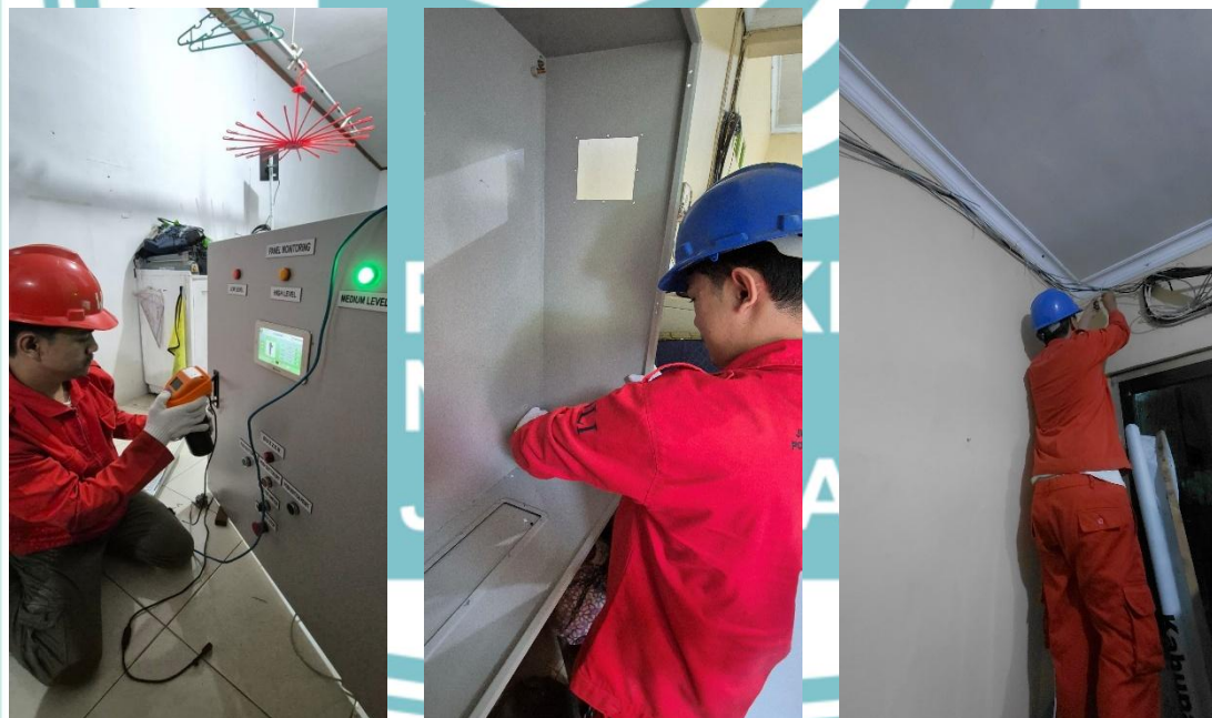
Lampiran 5.4. Pengujian Sensor dan Pemasangan Alat
