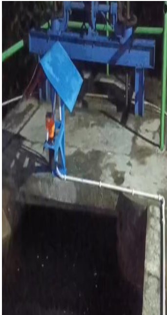
Lampiran 6.1. Pemasangan Sensor Ultrasonik
