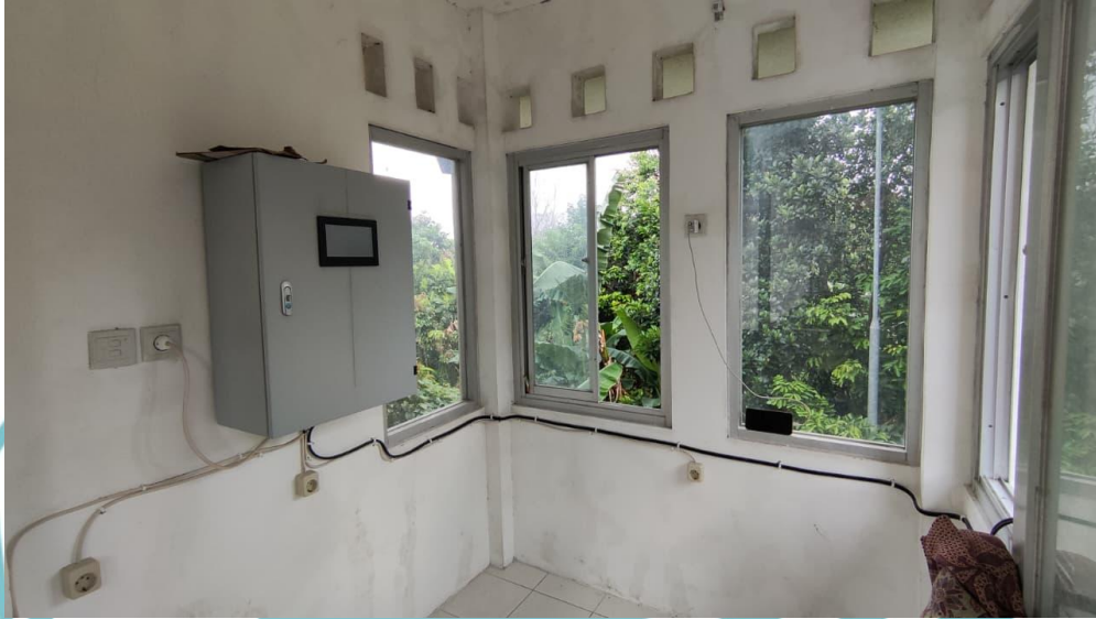
Gambar 3. 6 Lokasi Pemasangan Box Panel & Kotak Kontak
