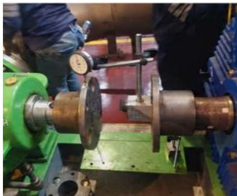
Gambar 3 pengecekan keselarasan antara poros motor dan pompa
