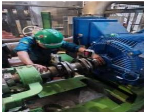
Gambar 5 pemasangan coupling antara motor dan pompa
