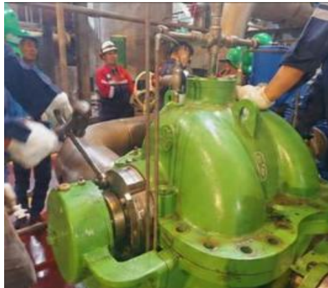
Gambar 4 pembongkaran bagian casing atas pompa
