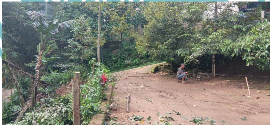
Gambar 4.2 Pekerjaan Stake Out Sumber : Data Penulis
