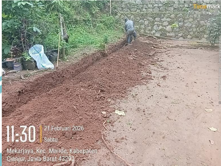
Gambar 3. 6 Pekerjaan Galian Pondasi Sumber : Data Penulis
