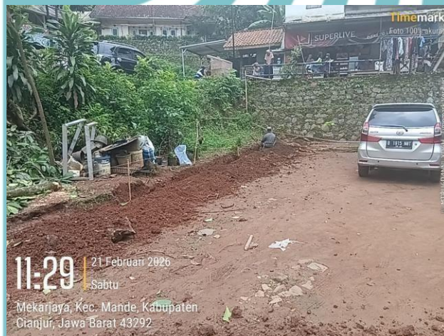
Gambar 3. 4 Kondisi di sebelah Selatan Sumber : Data Penulis
