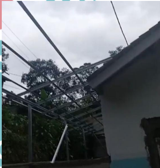
Gambar 4.15 Pekerjaan Rangka Atap Sumber : Data Penulis
