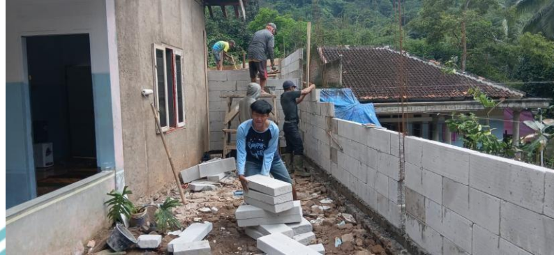
Gambar 4.12 Pekerjaan Dinding Sumber : Data Penulis
