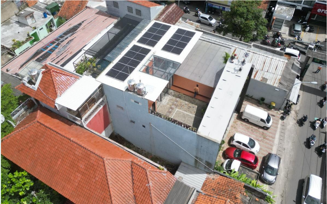
Lampiran 1 Foto Lokasi Penempatan Solar Panel
