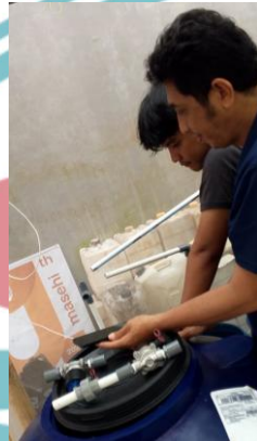
Gambar 3.6 Proses Pemasangan Pipa dan Solenoid Valve
