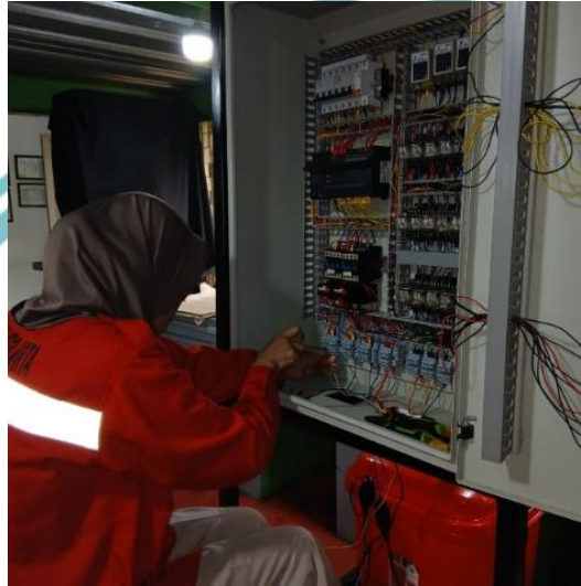
Gambar 3. 7 Proses Penyambungan atau Wiring
