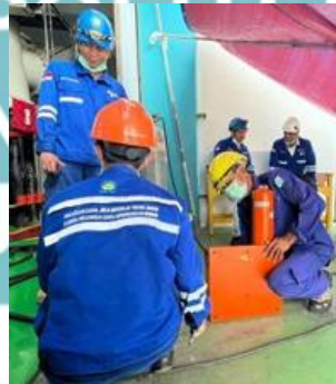
Lampiran 8. Hasil Uji Gas SF 6 pada kompartemen Busbar
