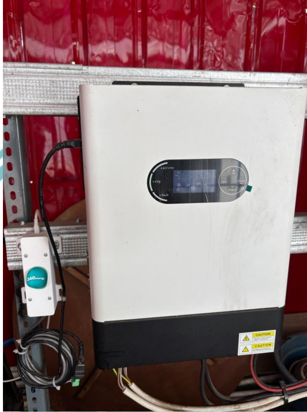
Lampiran 1. Tampak depan inverter yang terpasang IoT gateway
