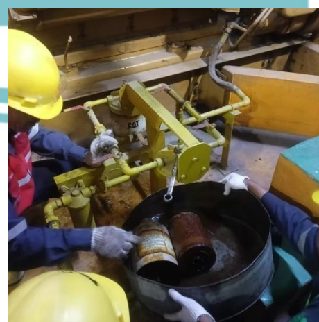
Mengamati pembersihan filter bahan bakar pada unit 2
