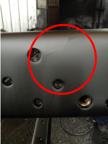
Lampiran 4 Dokumentasi Bentuk Defect
