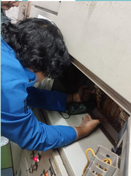
Lampiran 6. Pengecekan Amper Meter Pada Setiap Panel Saat Pembangkit Beroperasi
