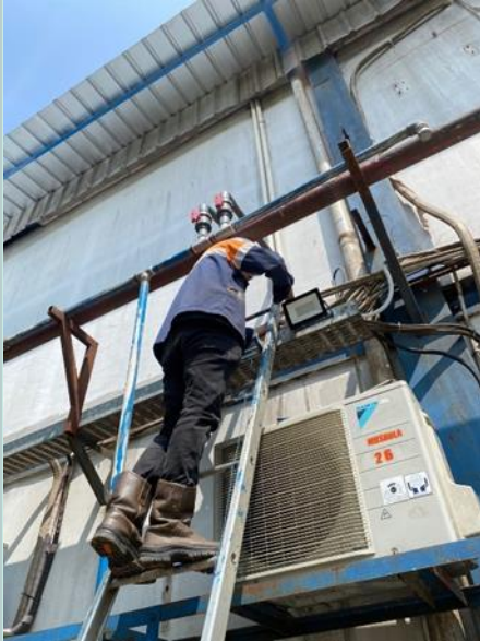
Lampiran 6. Pengecekan Amper Meter Pada Setiap Panel Saat Pembangkit Beroperasi
