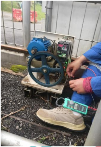
Memperbaiki motor listrik gerbang masuk
