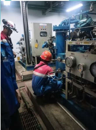
Mengambil data vibrasi air compressor
