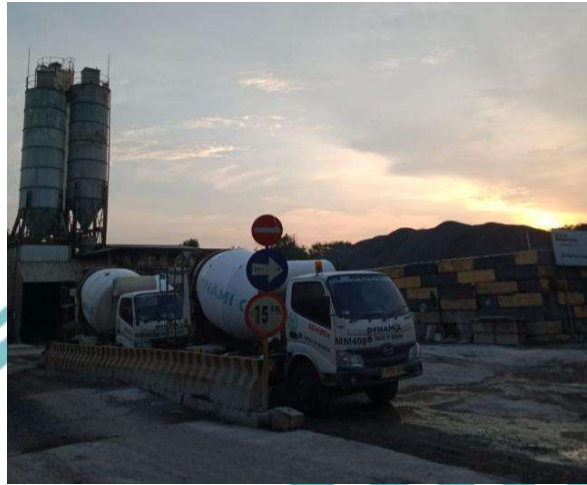
Gambar 1. 3 Batching Plant Gedangan Surabaya Sumber: Dokumentasi Pribadi
