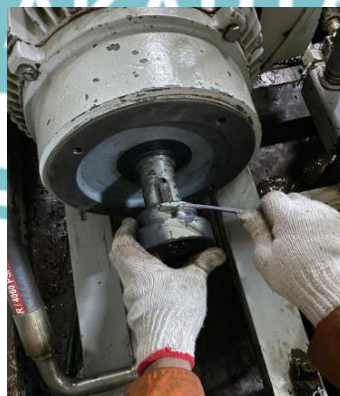
Pengecekan Coupling Pompa
