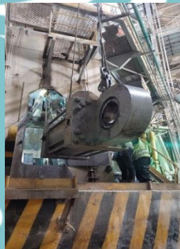
Penggantian Silinder Hidrolik
