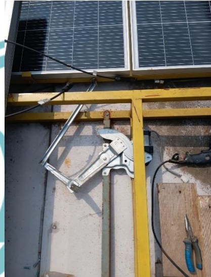
Lampiran 6 proses pemasangan alat
