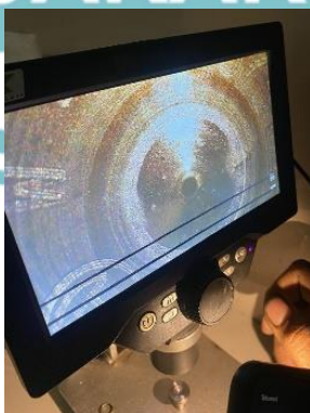
Komponen yang rusak
