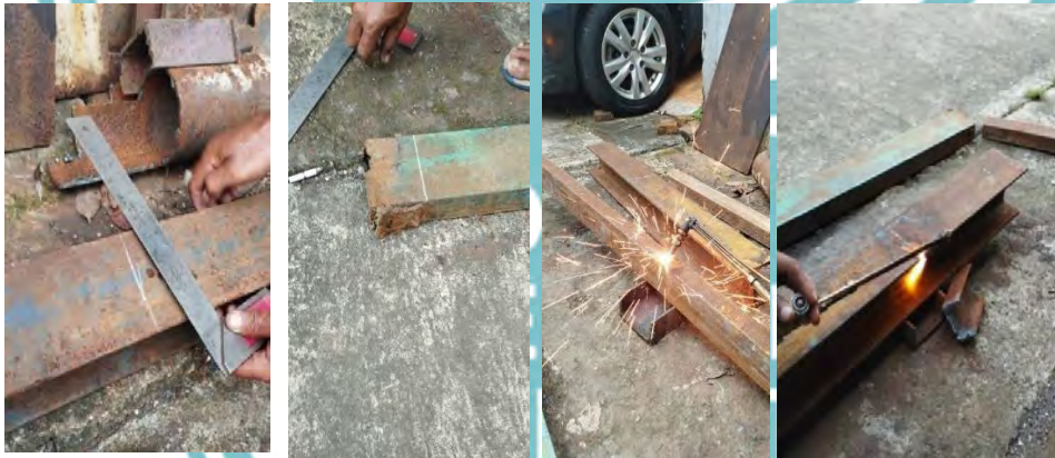
Proses Pemotongan Besi H-beam dan Besi UNP untuk rangka
