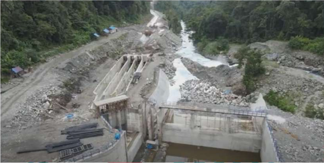
Lampiran 4 Proyek PLTM Kaur 1 dalam Pembangunan
