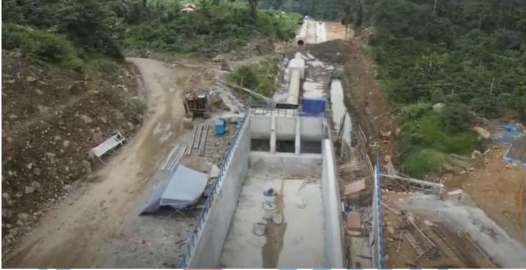
Lampiran 3 Proyek PLTM Kaur 1 dalam Pembangunan
