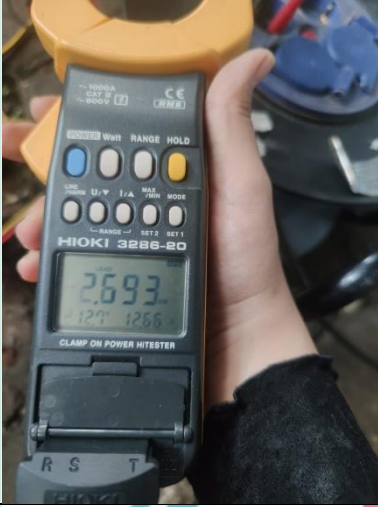
Pengukuran Daya Heater
