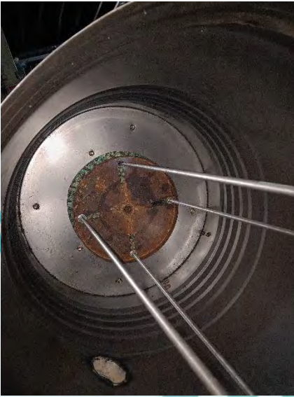
Lampiran 7 Pemasangan Pengunci Filter
